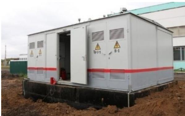
КТПНУ должна устанавливаться на твёрдом сухом основании специально подготовленном фундаменте. Фундамент должен быть подготовлен в соответствии архитектурно-строительной частью технического проекта.
