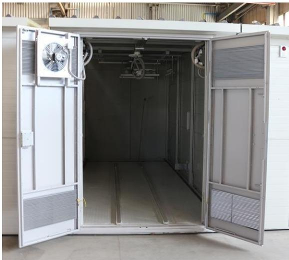
Входные двери в помещения РУ – огнестойкие, утепленные, металлические с двух сторон, с утеплителем из базальтового волокна внутри, открываются наружу и имеют самозапирающиеся замки, открываемые без ключа с внутренней стороны помещения. На дверях применяются огнестойкие вандал устойчивые ручки и замками для противопожарных дверей. Размеры дверного проема обеспечивают монтаж и демонтаж оборудования через него. Двери оборудуются доводчиками.
