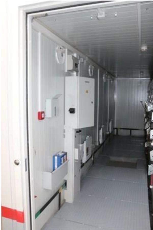
Комплектная трансформаторная подстанция поставляется с полностью смонтированной системой собственных нужд с целью обеспечения минимального объема строительного-монтажных и пусконаладочных работ непосредственно на месте установки и сокращению времени ввода в эксплуатации.
